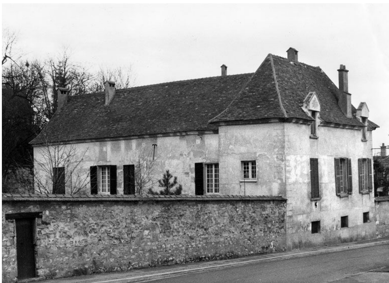
Façade postérieure avant transformation. Photographie. (Région Ile-de-France, Service Patrimoines et inventaire, Cote Pré-Inventaire).
