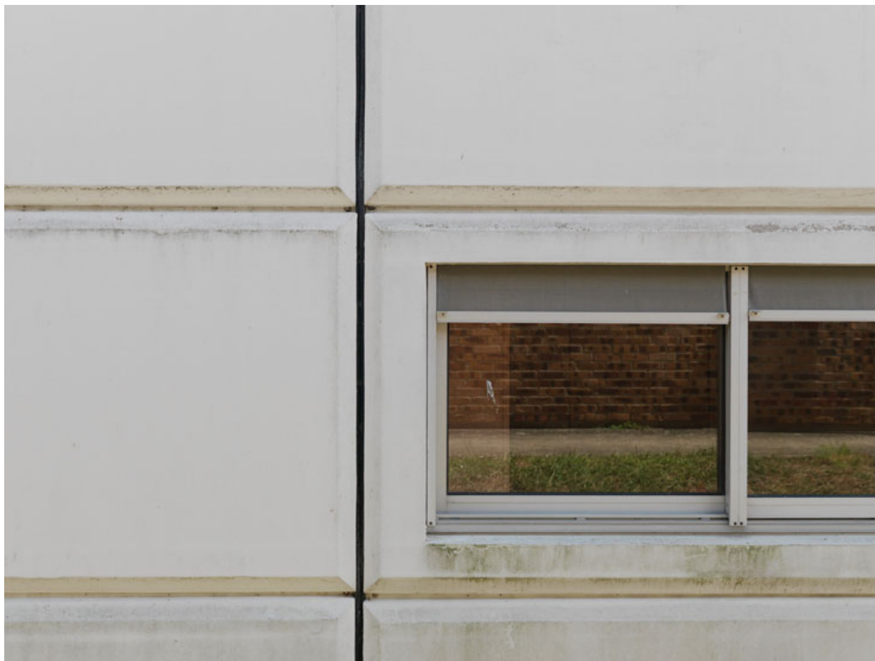
Laboratoire d'essais classique blanc de type Prouvé. Détail. Assemblage des panneaux. Traitement du joint.
