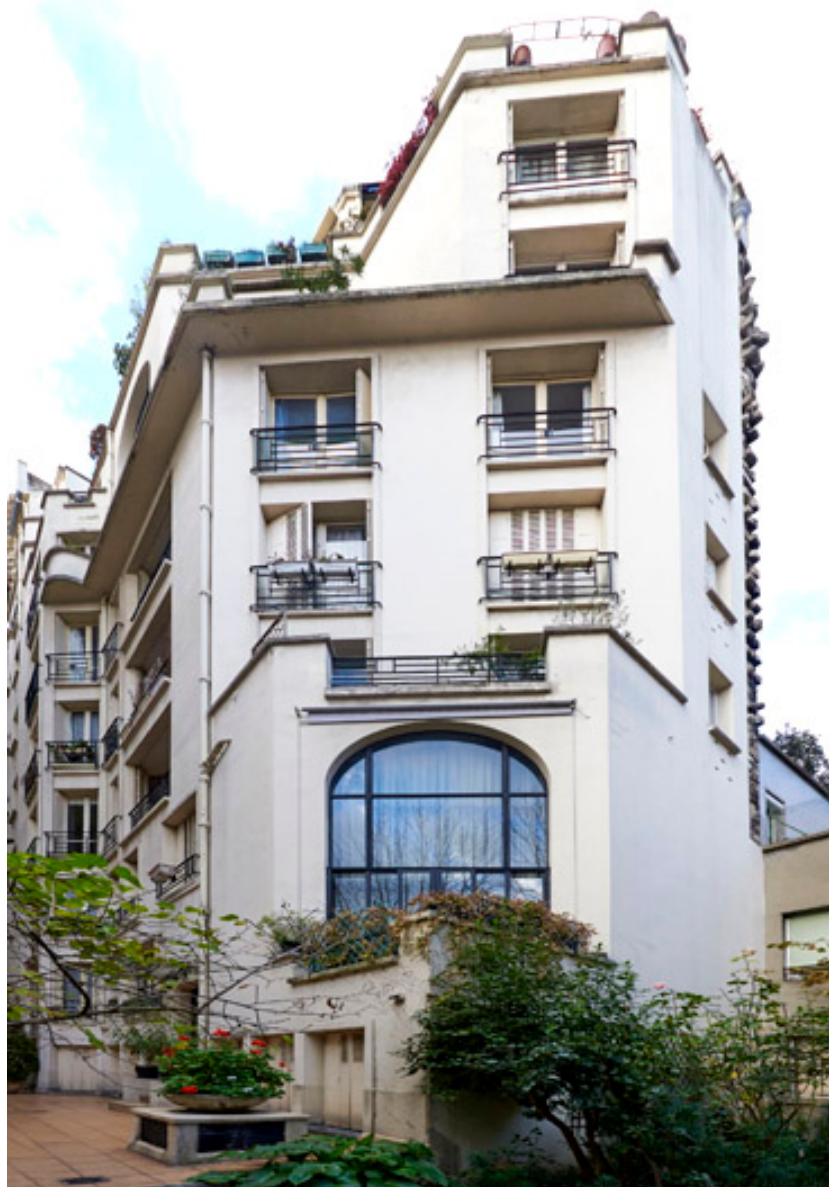
Vue de l'immeuble en retour, côté gauche.
