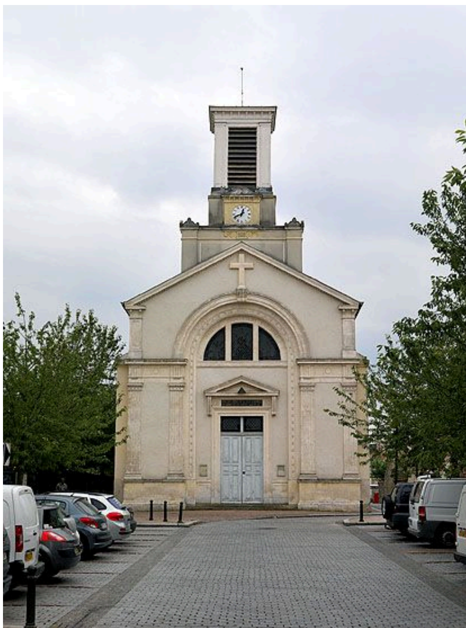
Vue d'ensemble de la façade.
