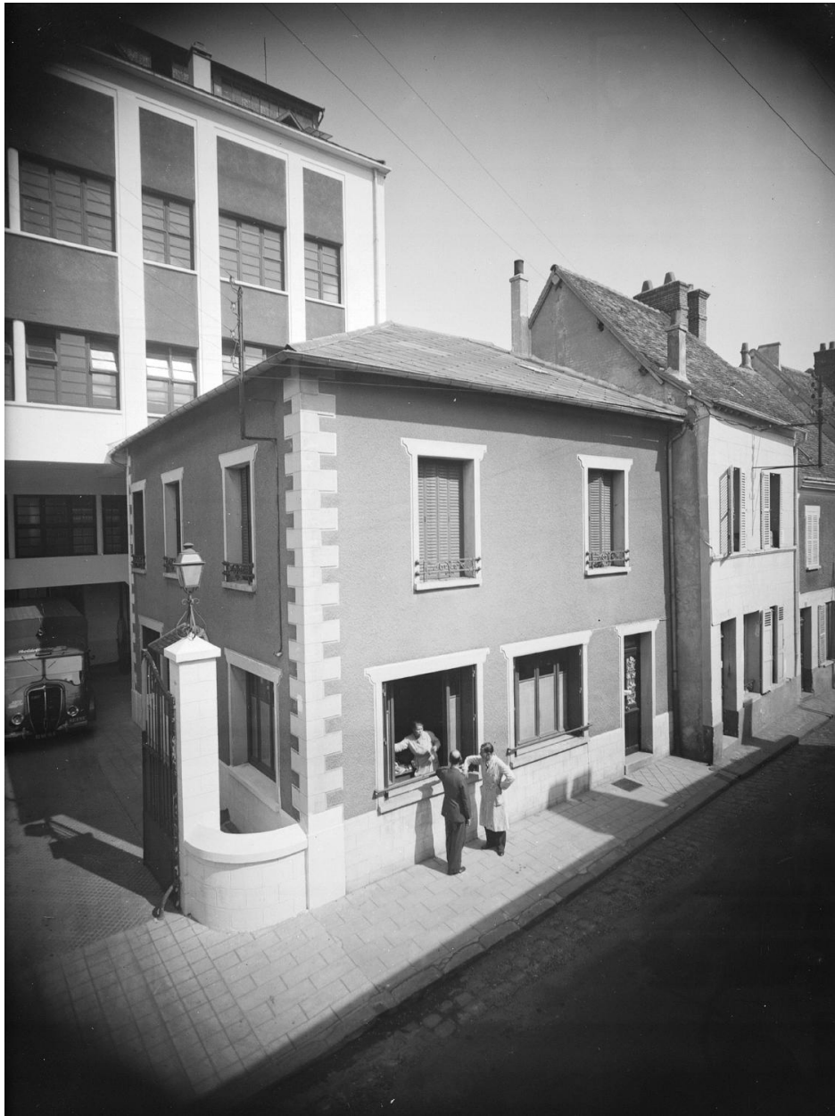
Vue de pavillon à droite de l'entrée de l'établissement, faisant office de bureaux.
