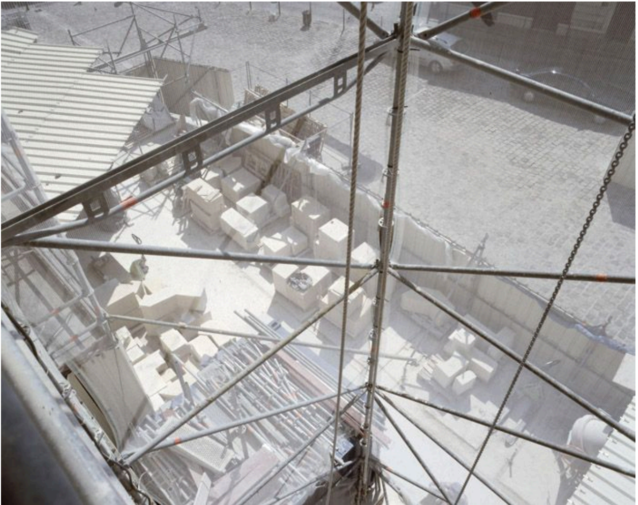
La façade occidentale : vue du chantier de restauration de la base de la tour nord (2008). Au sol, les pierres prêtes à être taillées.
