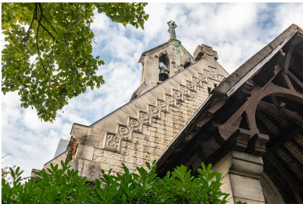
Chapelle Notre-Dame-des-Airs, façade principale, auvent, mur-pignon et clocher-mur
