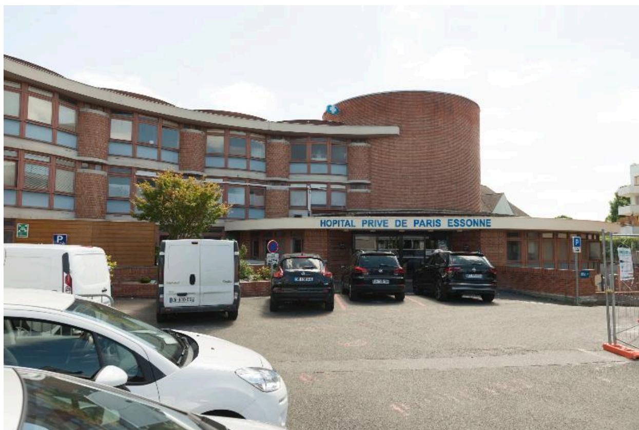
Vue générale de la façade principale.
