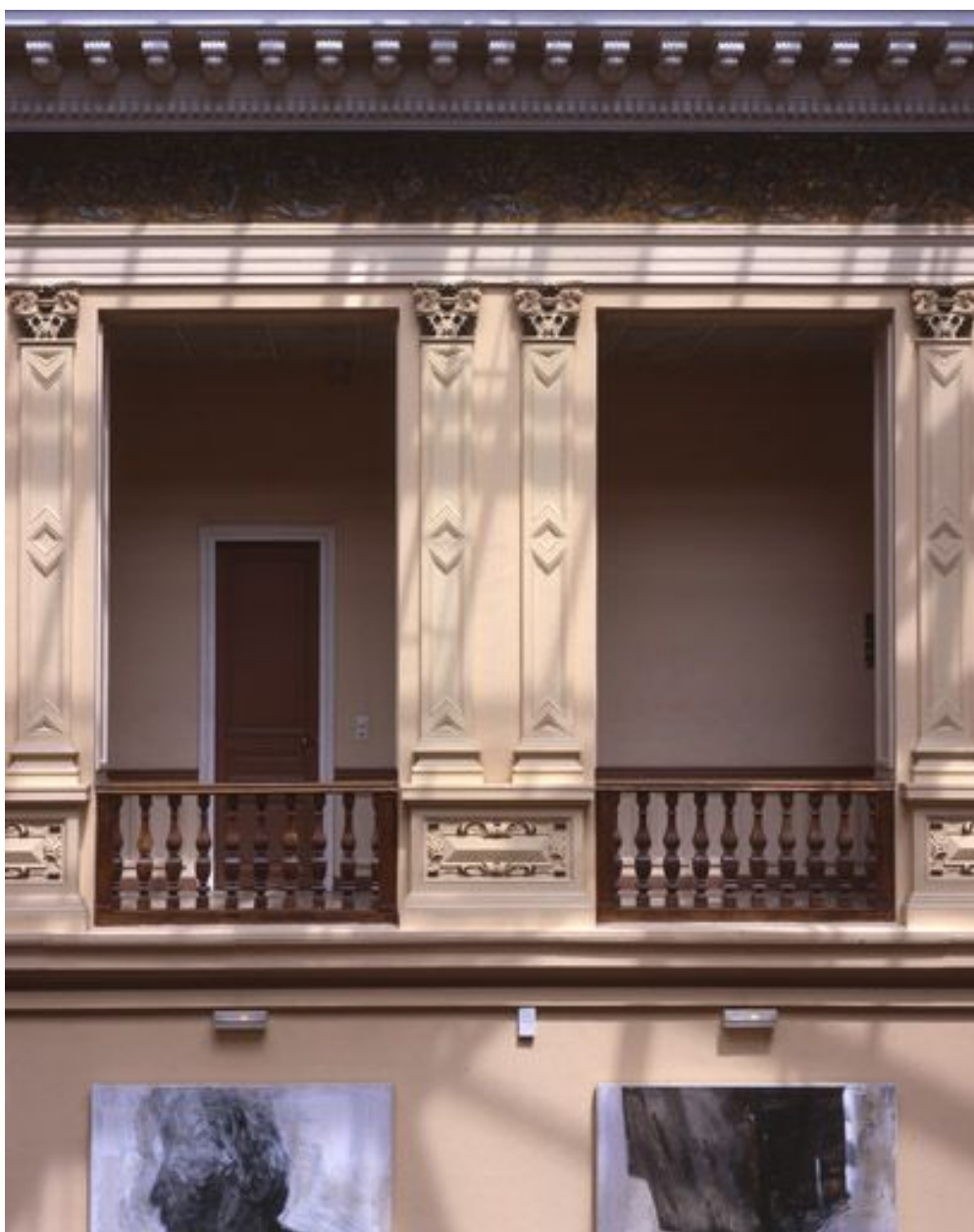
Détail de la galerie faisant à l'étage le tour de l'espace central.
