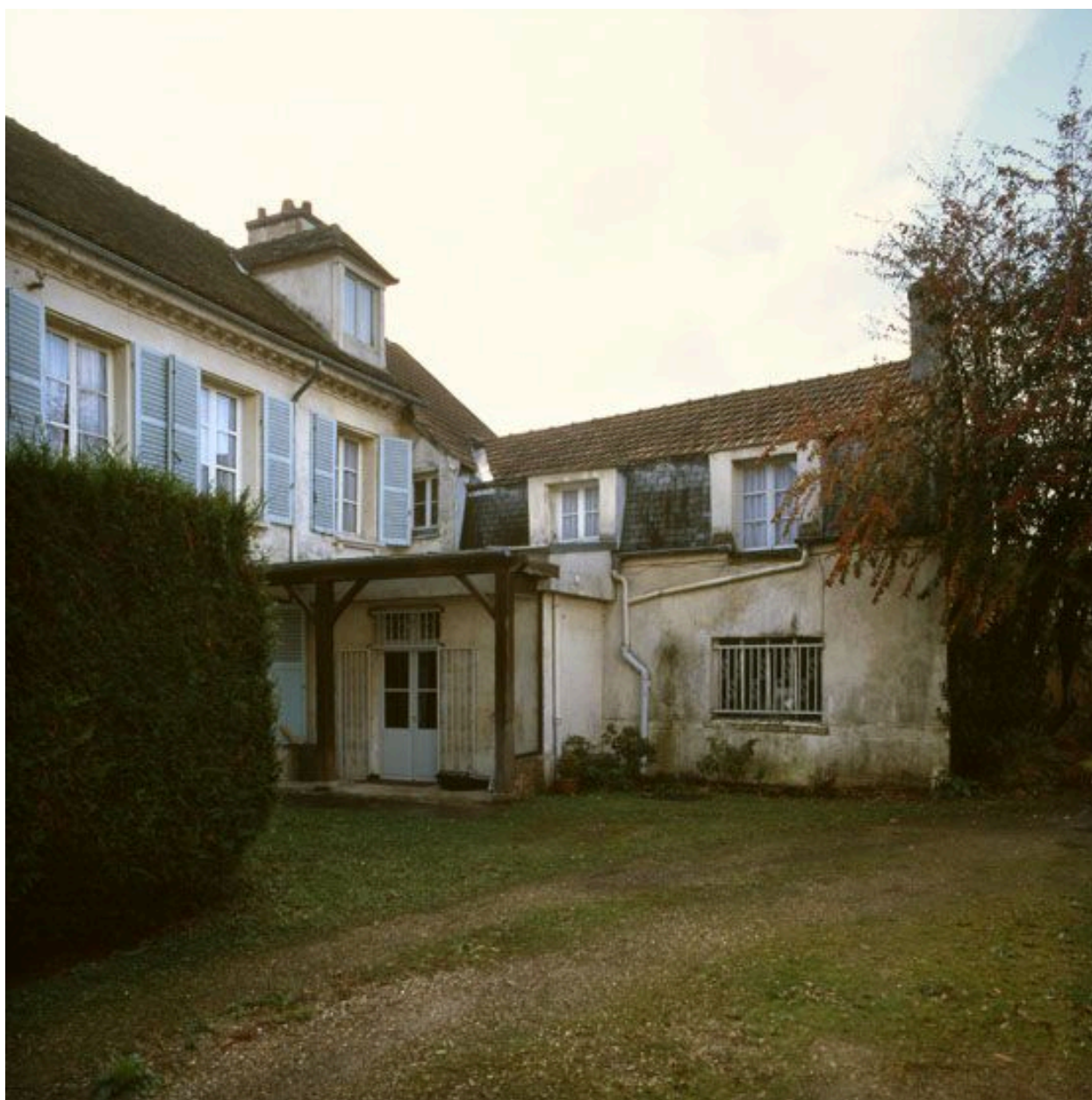
Vue d'ensemble de l'aile droite.
