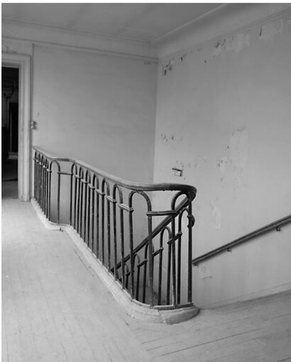
La rampe d'escalier, au niveau de l'étage.
