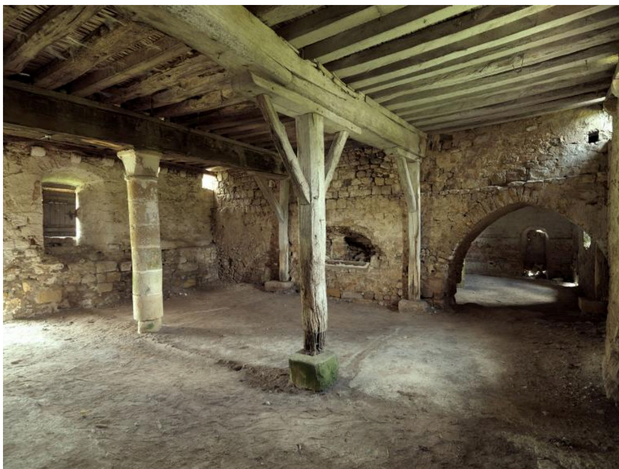
Vue sur la salle 2 de la grange des Beauvais depuis l'angle nord-ouest.
