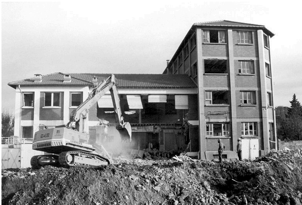
L'usine Vernin en cours de démolition. Photographie. (Collection particulière (M. Bouvet, à Melun))
