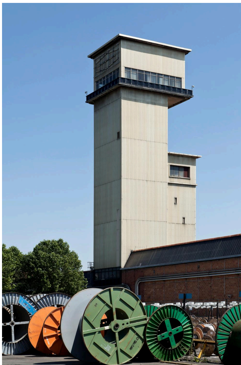
Tours accolées pour câbles haute tension, 1959 (30 mètres) et 1966 (50 mètres). (réf. Département de Seine-et-Marne : IVD77_2013_77_00338_NUCA)
