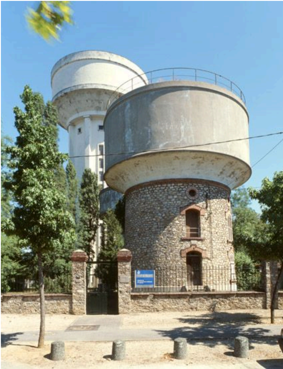
Vue d'ensemble de deux château d'eau, avenue Salvador Allende. Le premier porte la date 1907, l'autre a été construit dans l'entre-deux-guerres.
