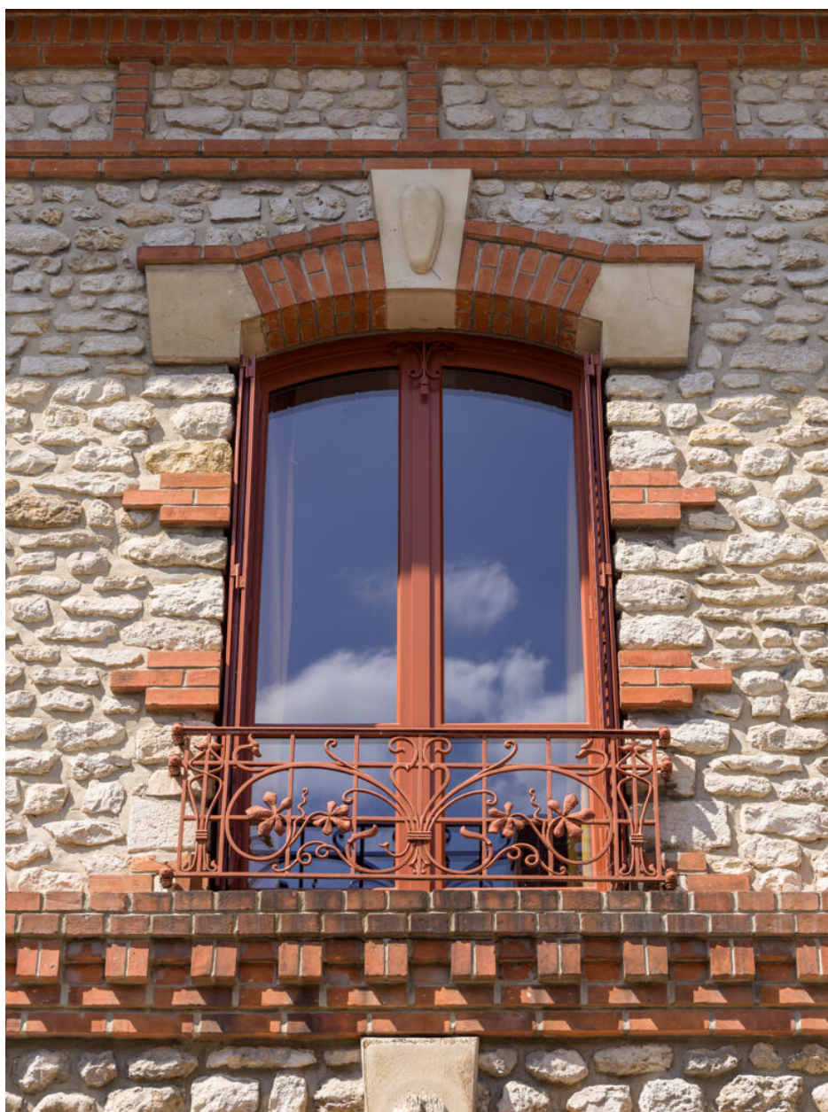
Fenêtre de l'étage.
