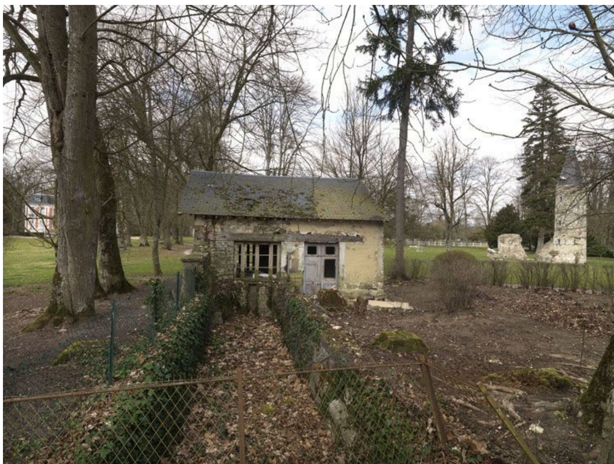
Canal d'aménée et vanne motrice, depuis l'est.
