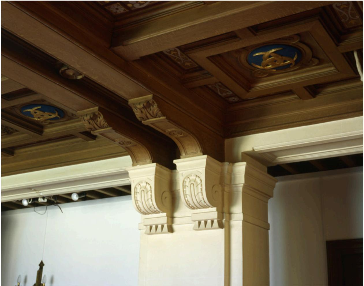
Villa Kermina, hall central : détail des corbeaux jumeaux formant entablement et supportant l'une des doubles poutres maîtresses du plafond à caissons.
