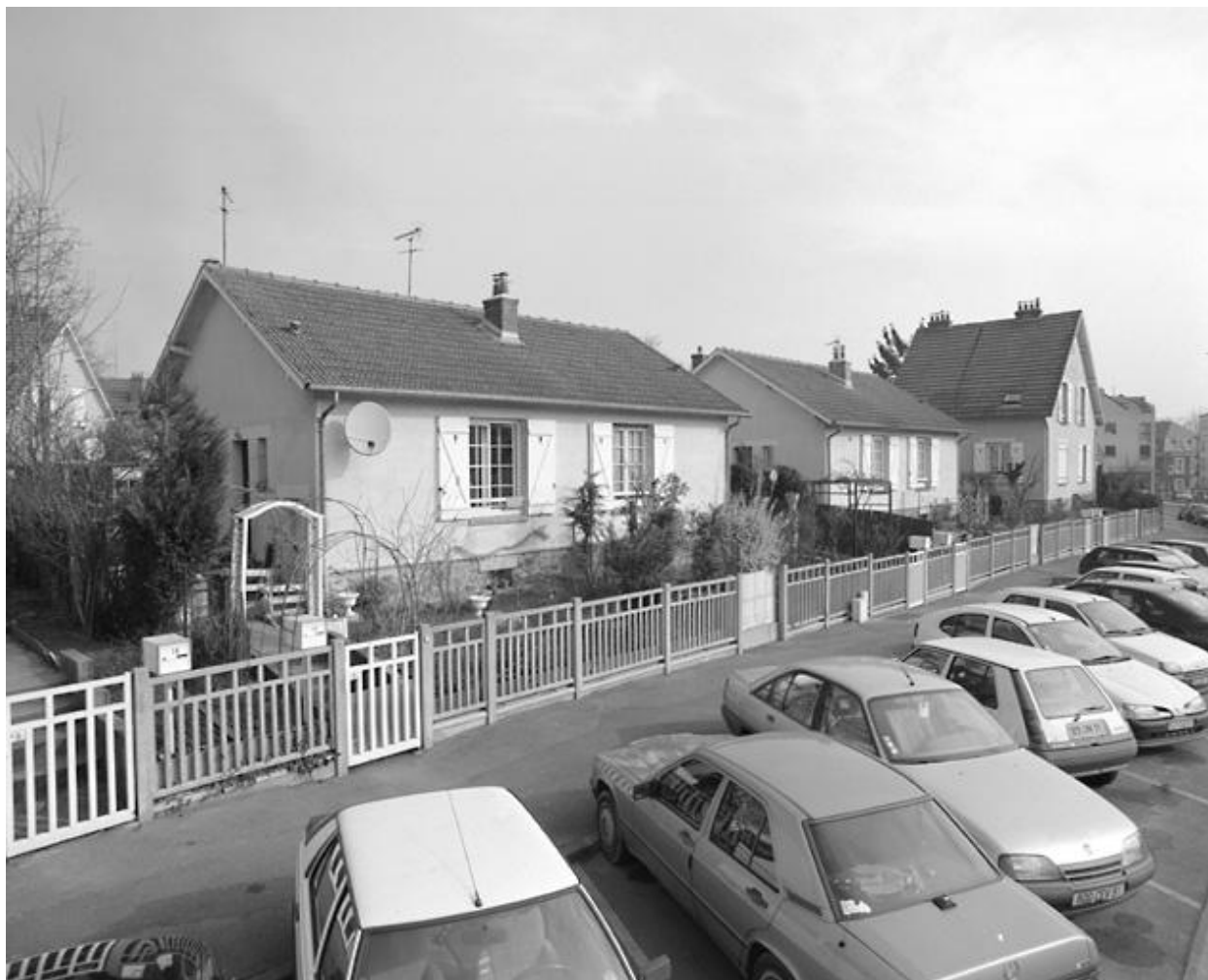
Vue sur l'avenue Jean-Pierre Sembat (deux pavillons 2 bis jumelés et un pavillon 1 bis jumelé).
