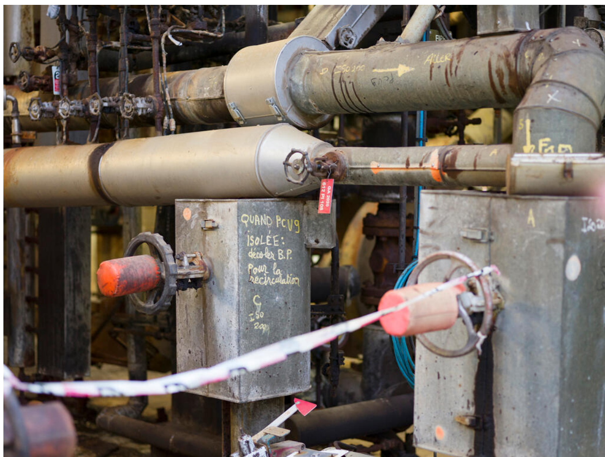
Unités Ouest - Zone de distillation (Unité 612). Devant le four 612 F1, détail de la tuyauterie d'alimentation fioul.
