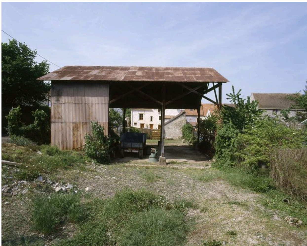
Vue d'un hangar agricole.
