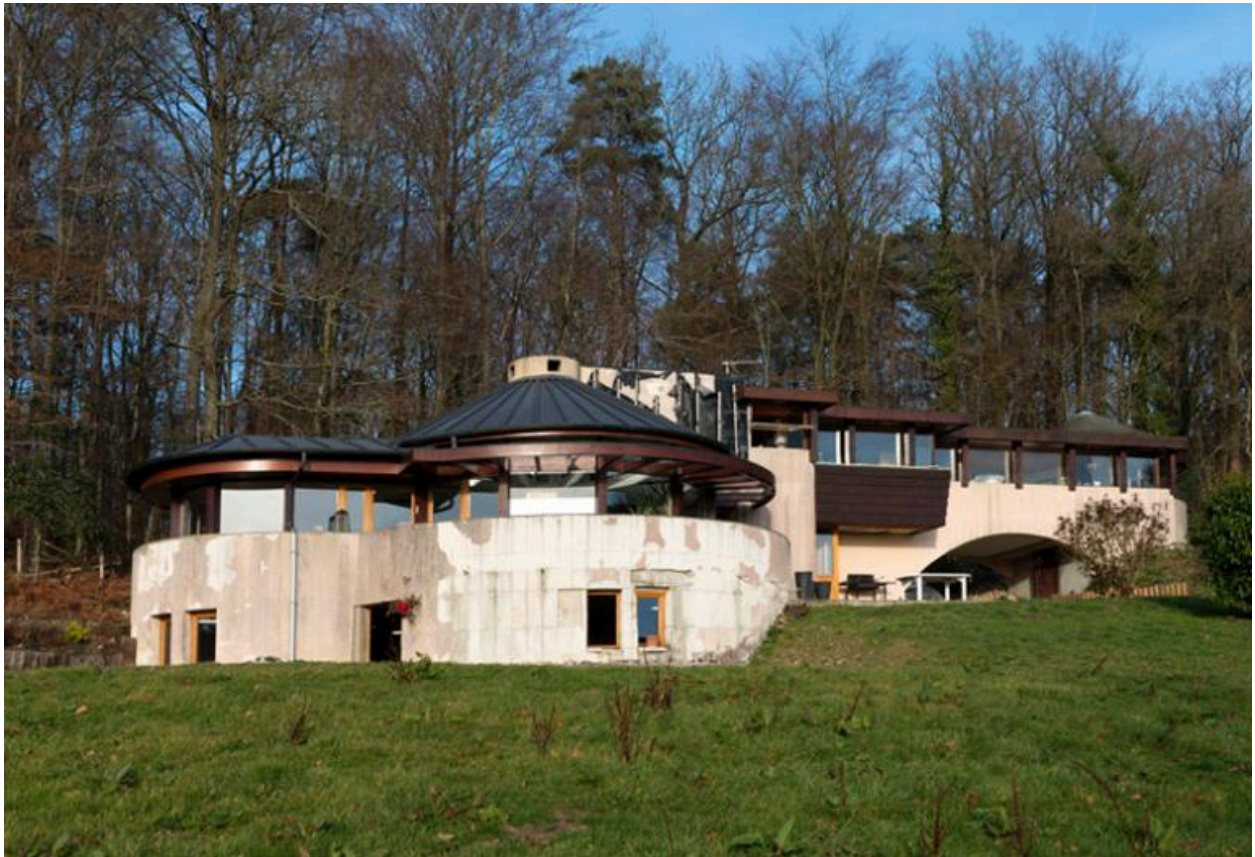
Vue générale de la maison prise du côté gauche.
