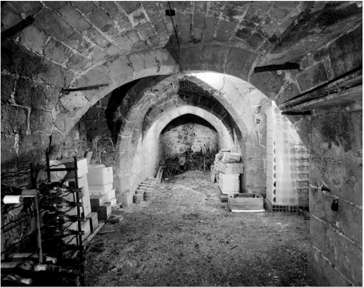
Cellier gothique : vue de la croisée d'ogives se trouvant à peu près au centre du cellier.
