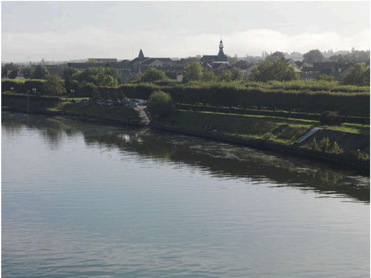
Bonnières-sur-Seine : quais aménagés vus depuis le pont vers l'amont.
