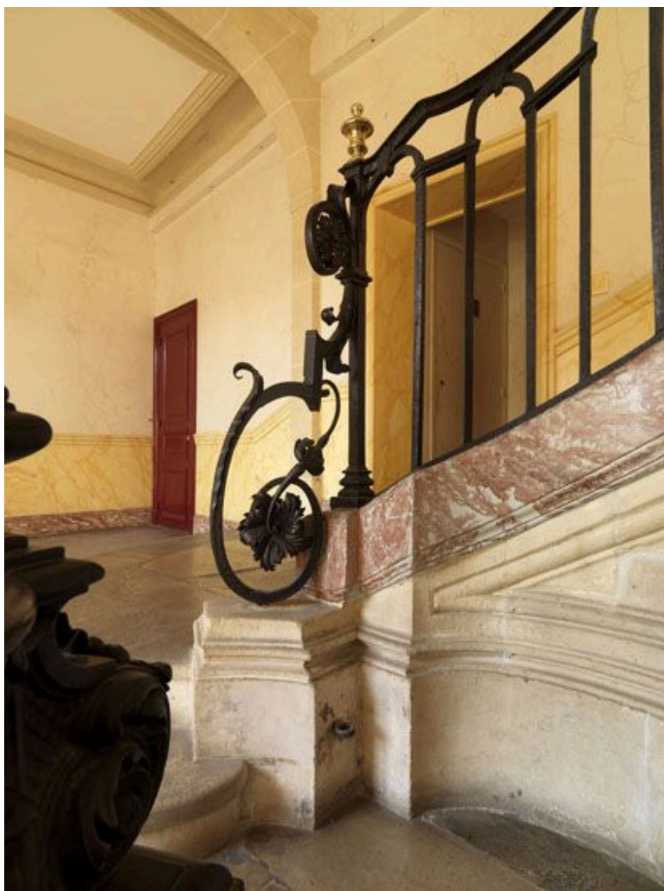
Vue latérale de la console de départ.
