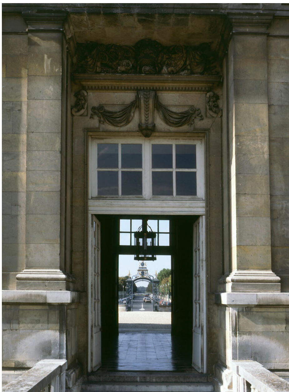
Vue traversante du vestibule du château.
