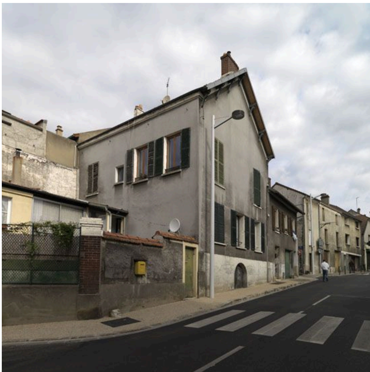
Chanteloup-les-Vignes. Une ancienne maison rurale avec accès extérieur aux caves, rue du Général Leclerc.
