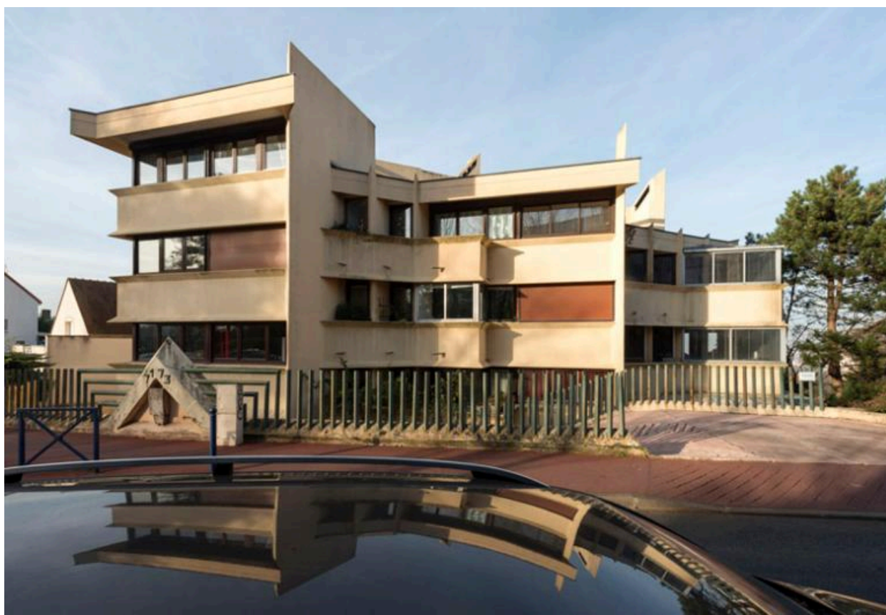
Vue frontale de la façade côté rue.
