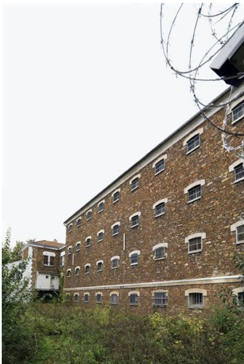
L'élévation sud du bâtiment cellulaire, vue depuis le sud-est.
