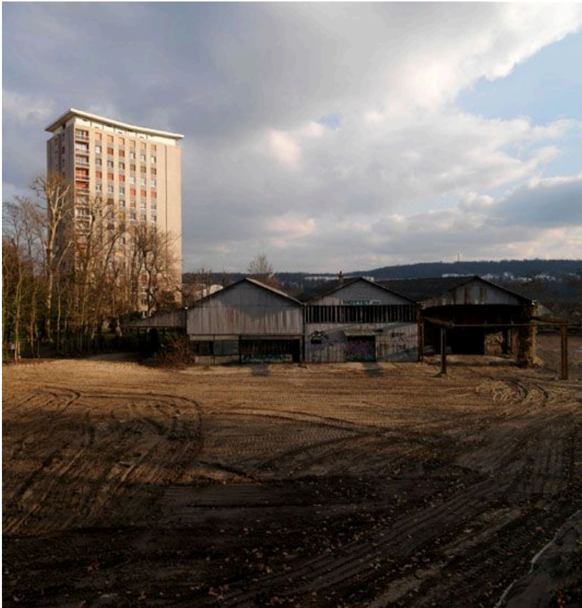
Hangars industrielles ayant appartenu a la société PIC, situés a proximité de la gare d'Avon.
