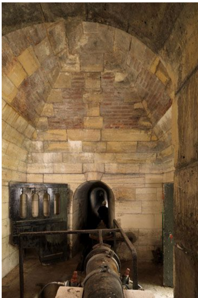
Arcueil. Vue de l'intérieur du regard XIII : début du pont-aqueduc.
