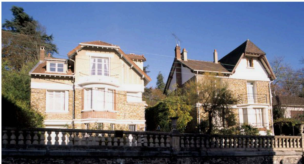
Maisons aux n° 10-12, boulevard Aristide-Briand, édifiées en surplomb de la voirie. Celle de droite date de 1936 (AM Melun, 1 Fi 1267).
