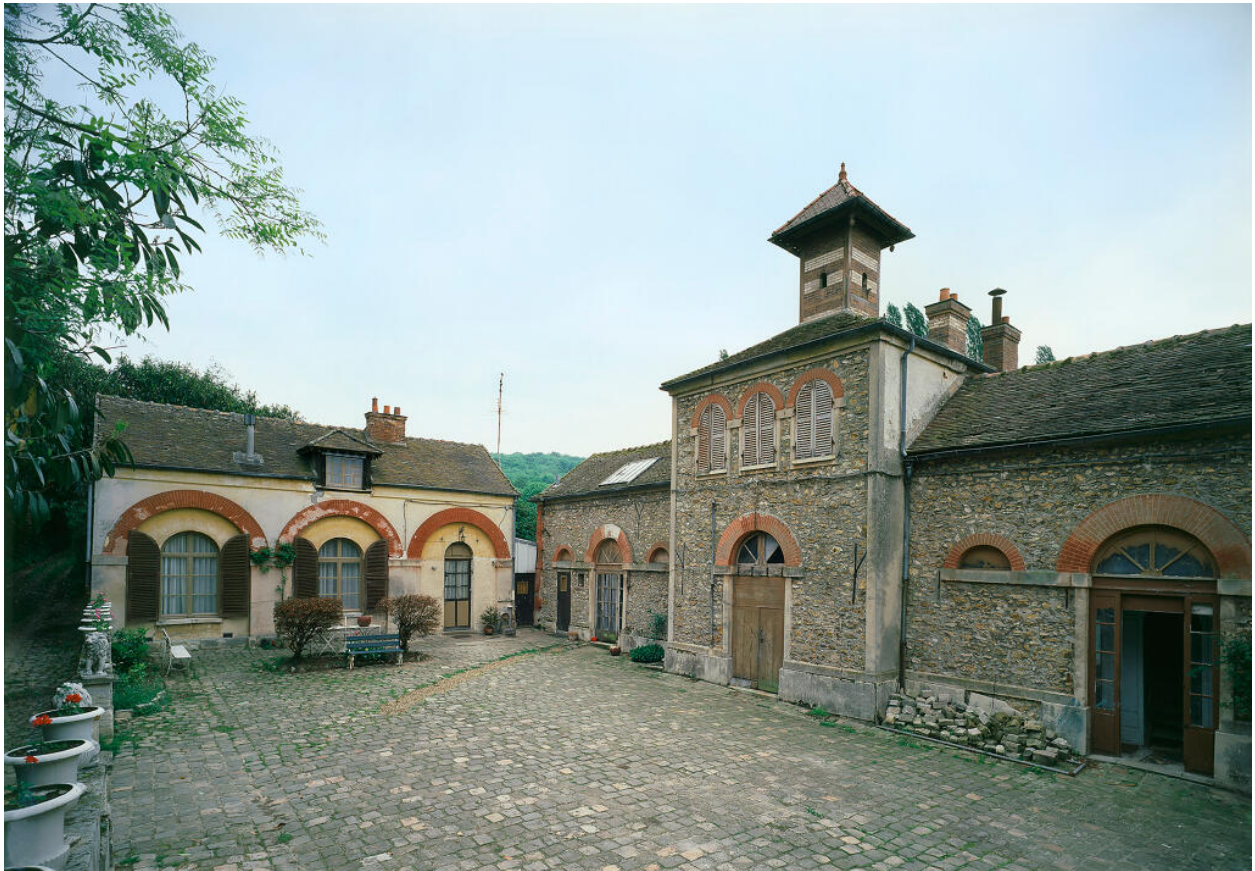
Les communs : corps central et corps latéral gauche.
