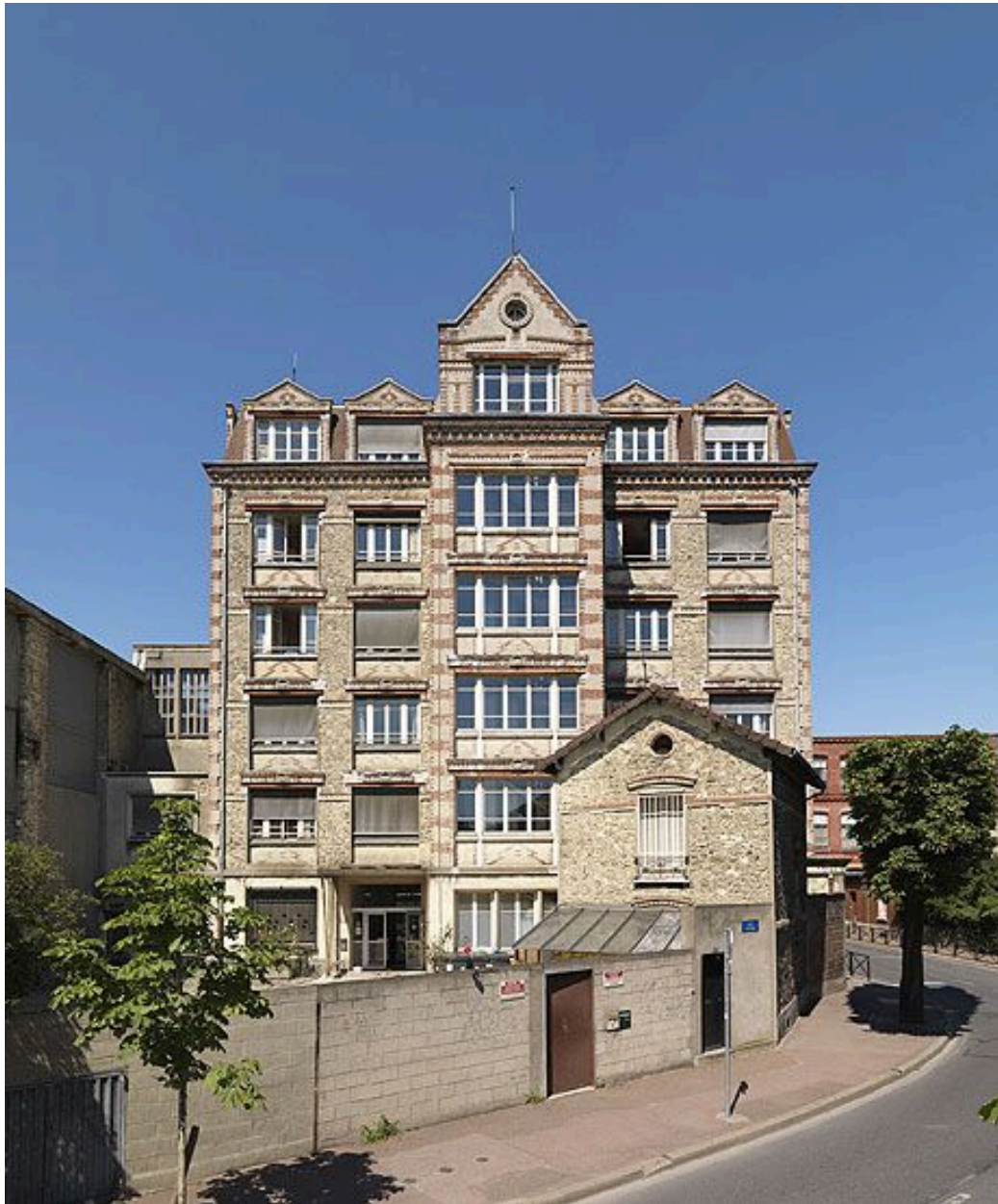
93, Courneuve (La), usine de construction mécanique Mecano, 33 avenue Victor-Hugo. Elévation générale du bâtiment administratif.
