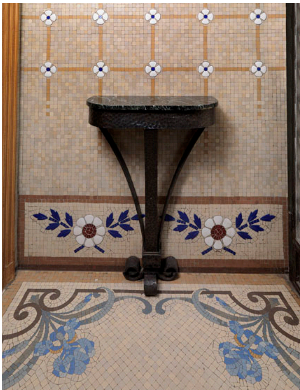
Vue de la partie inférieure du panneau de mosaïque ornant le vestibule d'entrée.
