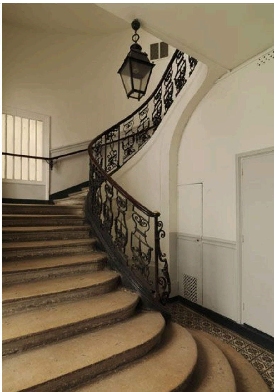
Vue d'ensemble du départ de l'escalier.
