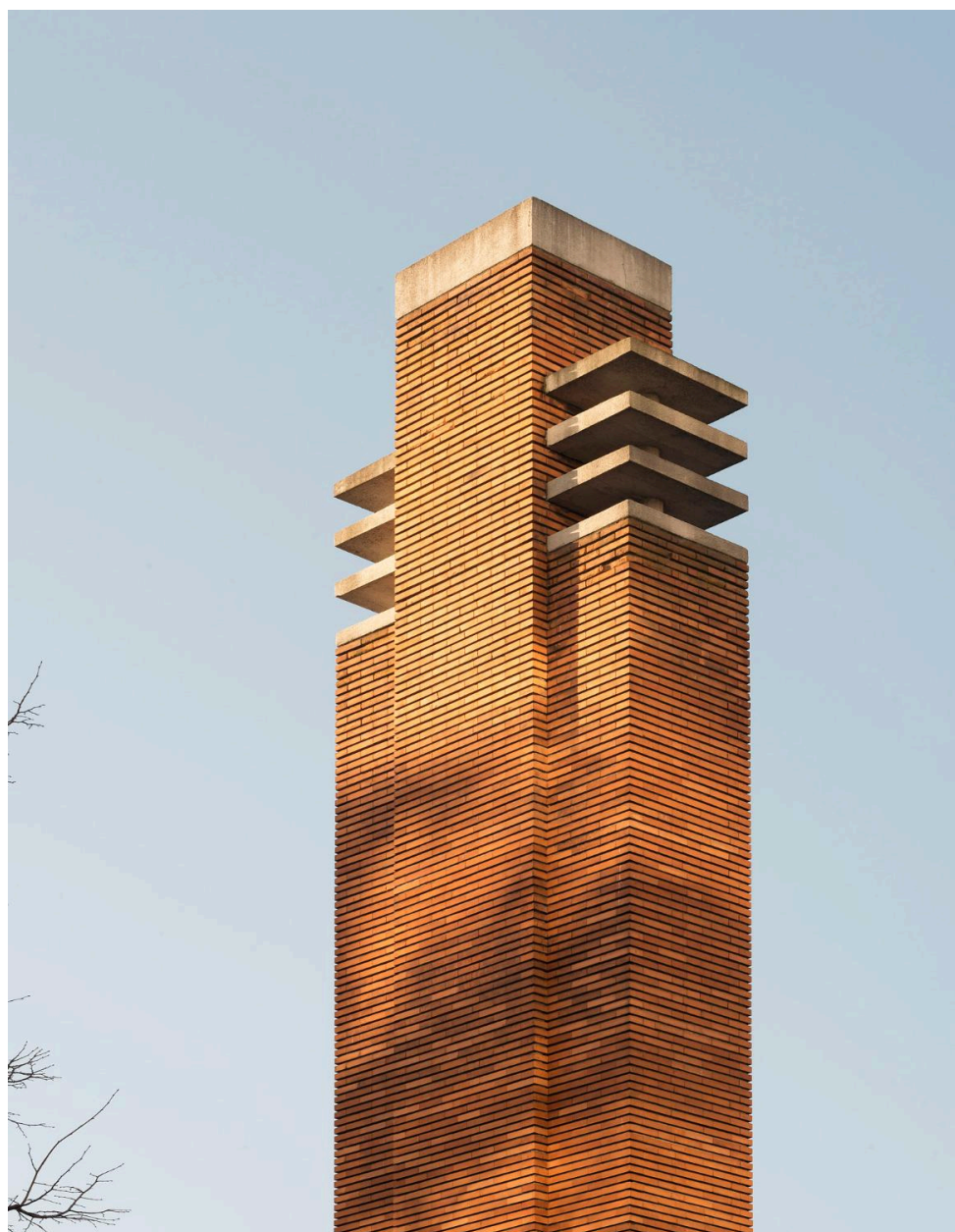
Détail de la cheminée et de ses volumes étagés.
