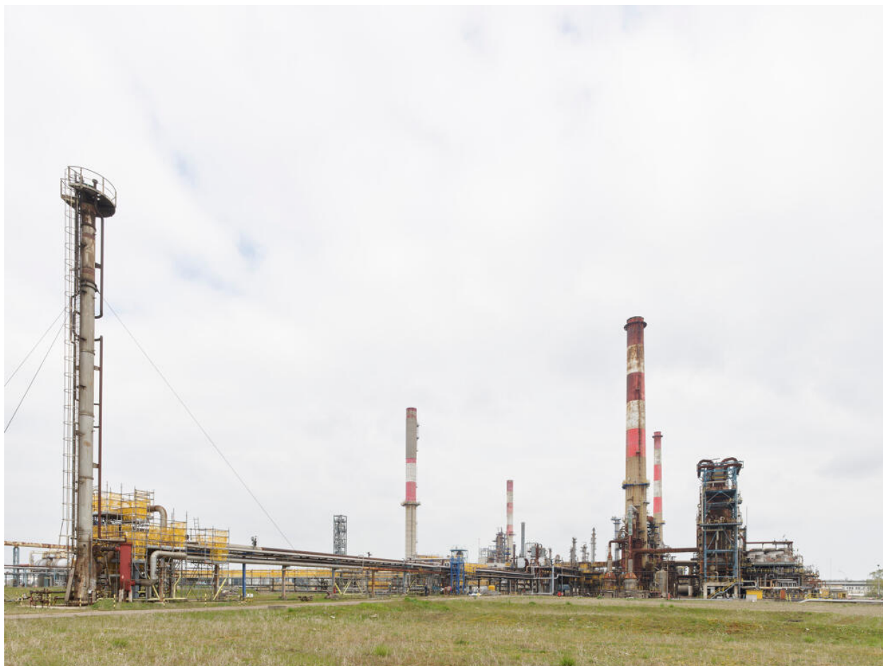
Unités Ouest - Zone des torches. À gauche, vue sur la petite torche. Au fond, les unités de production.
