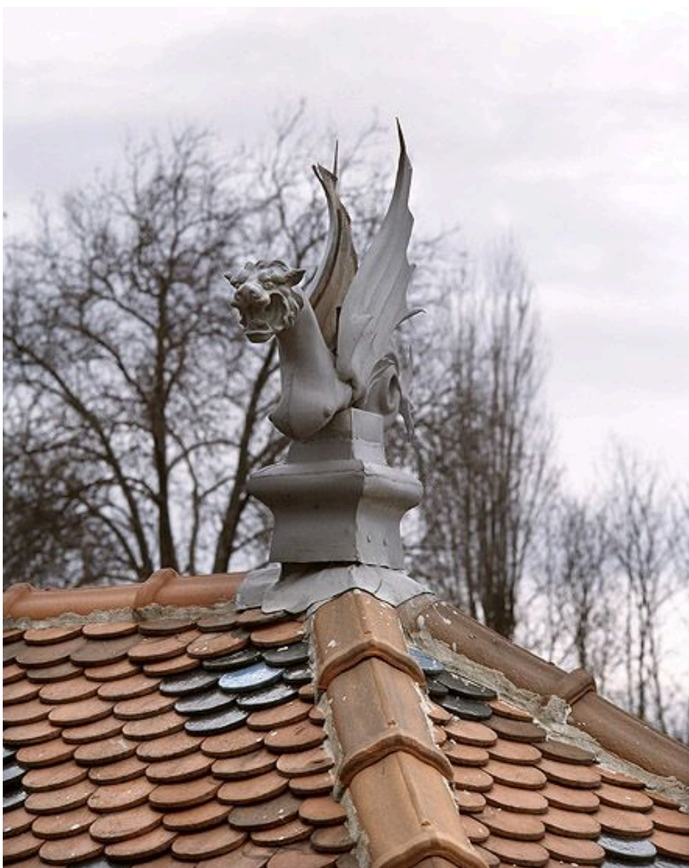
Une acrotère et un détail du toit aux tuiles vernissées en écaille.
