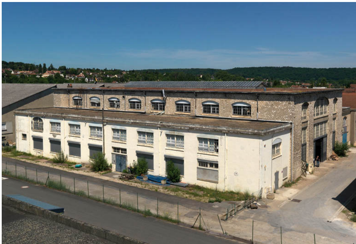
Vue générale du magasin général (1915).
