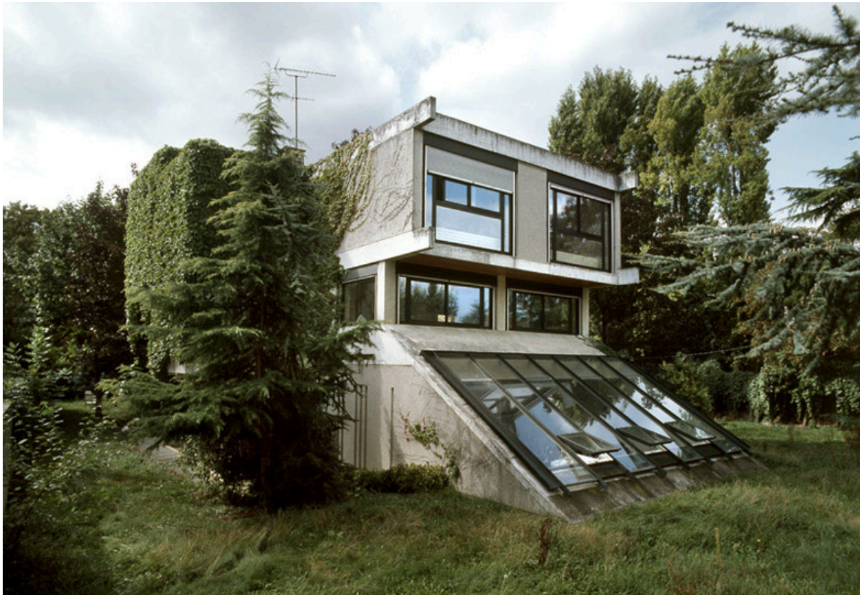
Maison, 17 quai d'Artois. Vue de la façade arrière.
