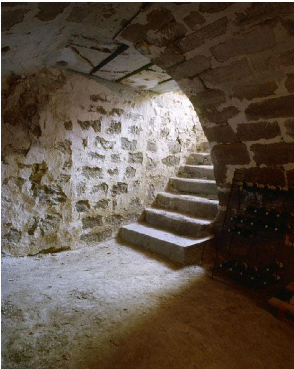
Escalier desservant la cave.
