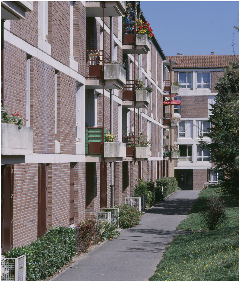
Une façade : les affleurements des dalles de béton trahissent la structure constructive.
