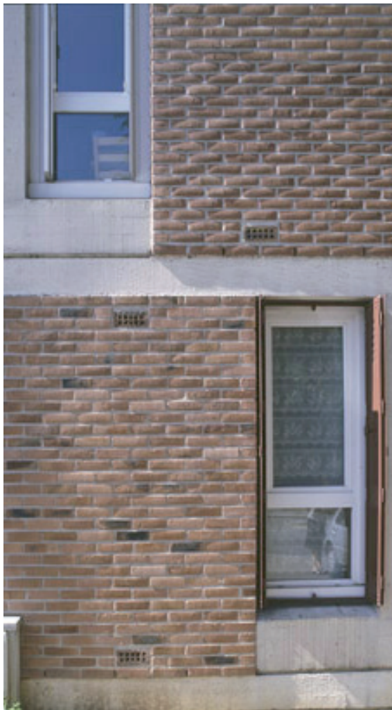
Détail de mise en œuvre.
