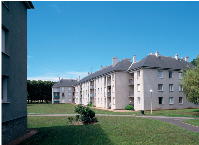
Le Domaine de Villiers : bâtiments collectifs au sud du château.
