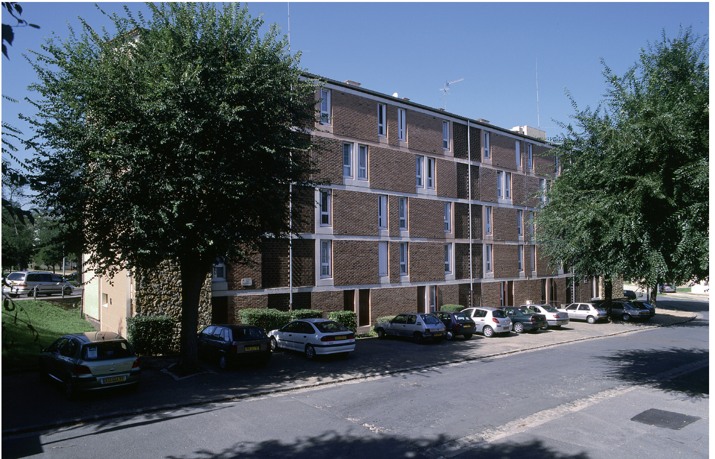
Immeuble R+4 : les briques ferment les espaces de la structure constructrice en béton.
