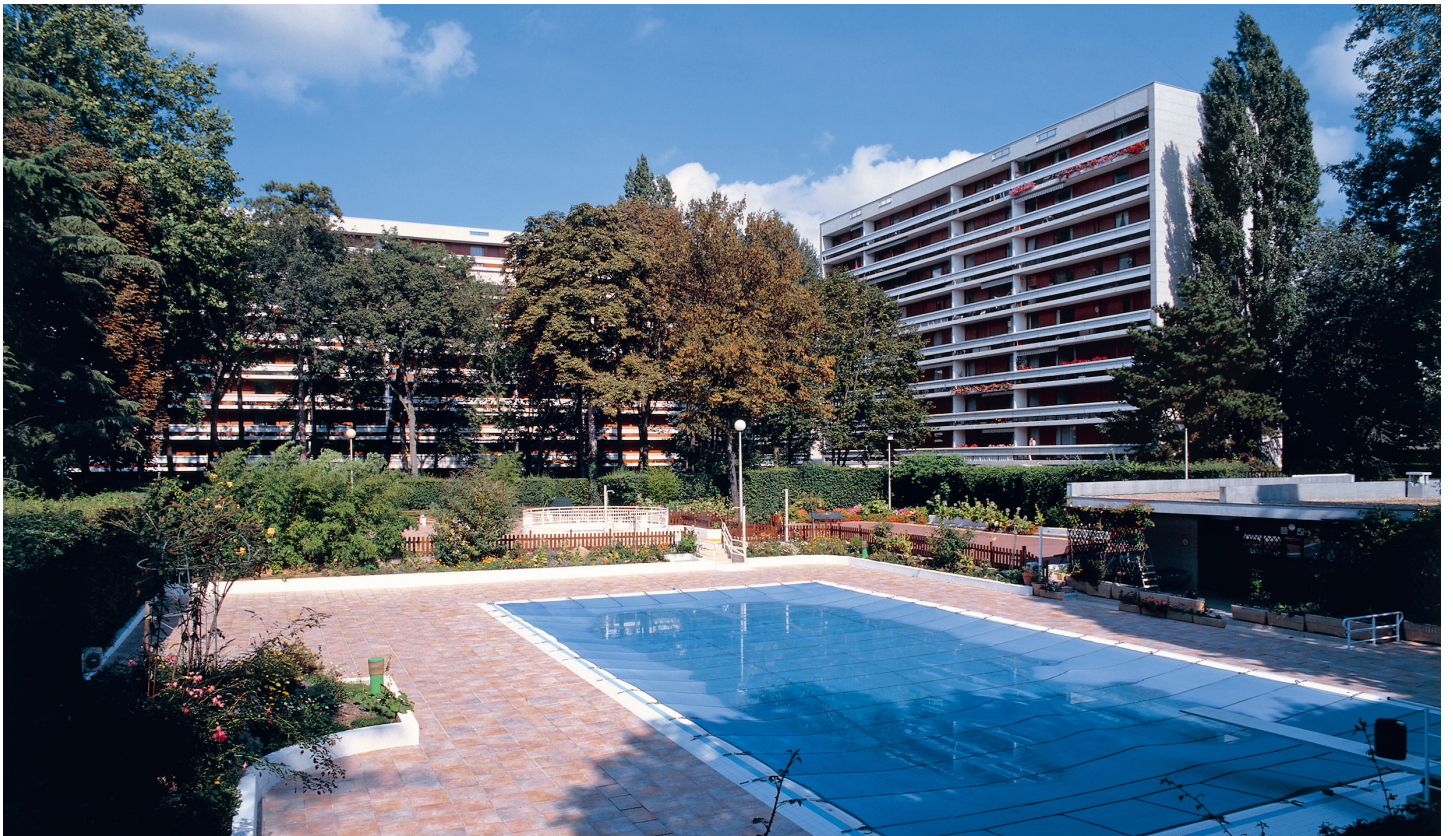
L'Orée de Sénart : les immeubles n'occupent qu'une faible superficie du parc permettant ainsi de maintenir son aspect paysagé.
