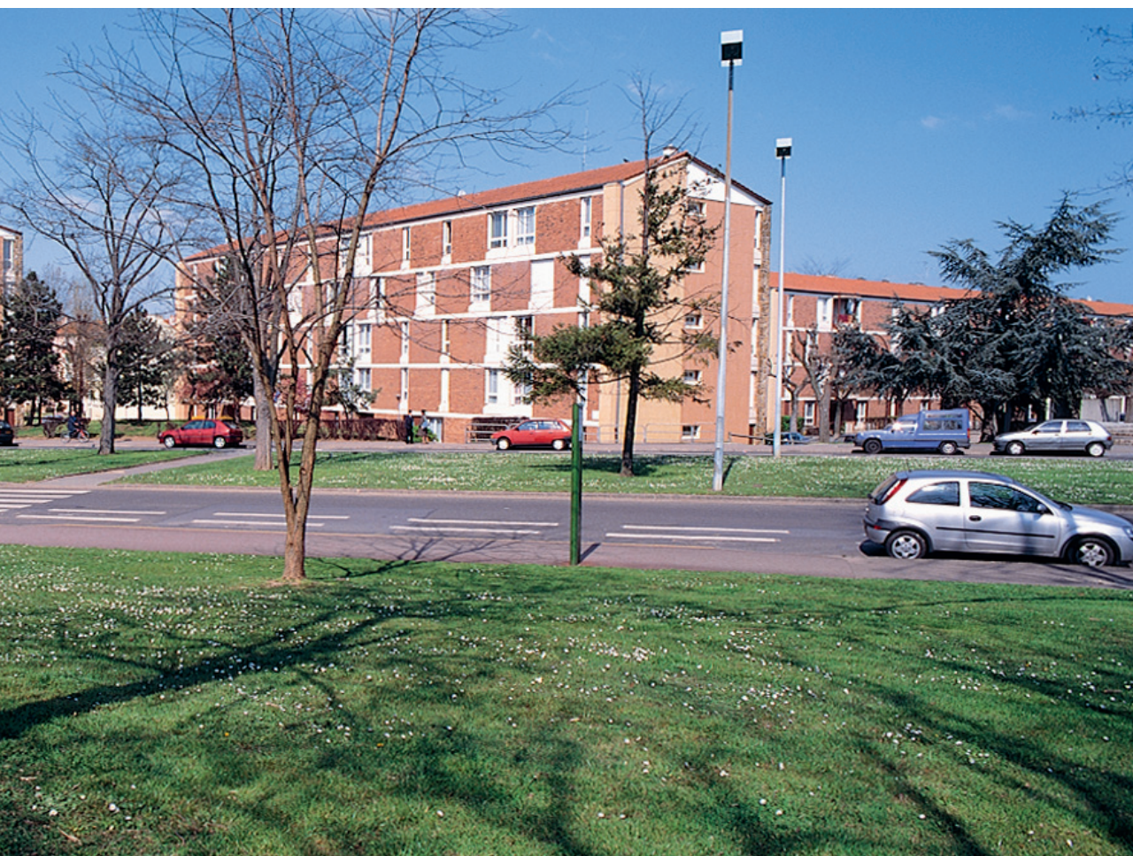
Vue générale : le refus du gigantisme caractérisent les recherches de l'Atelier d'Urbanisme et d'Architecture auquel appartient Chemetov.
