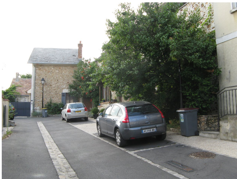
La Grande Cour aujourd'hui, avec son revêtement bituminé.
