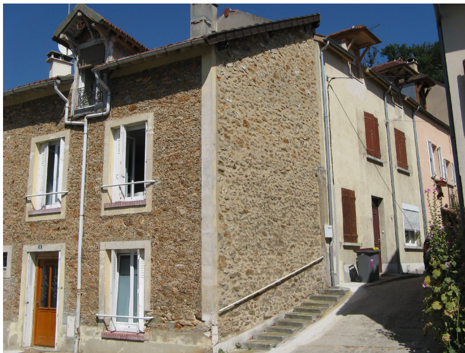
L'une des quatre cours communes recensées dans Vauhallan, ici rue de la Petite Fontaine.
