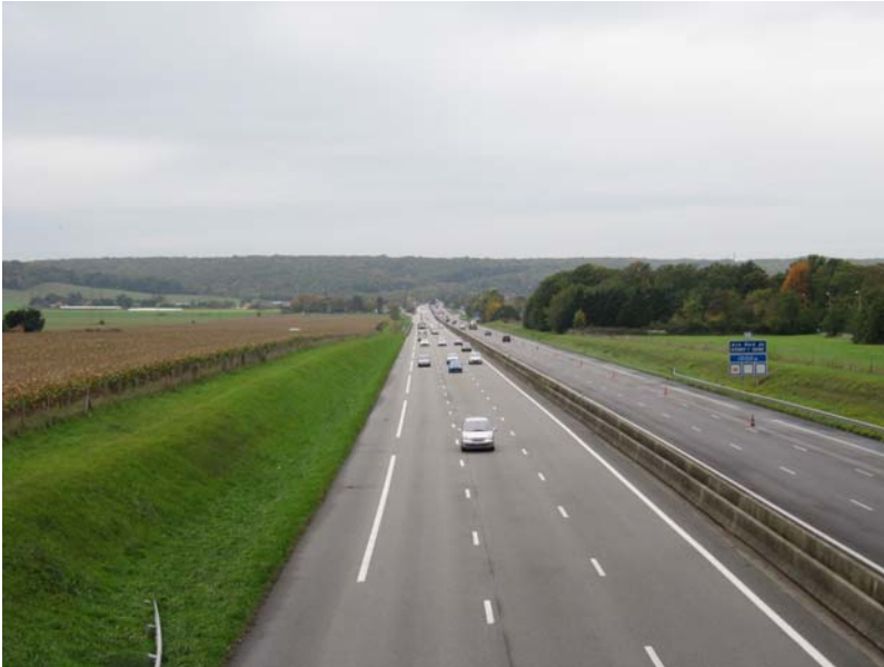
rssp005 : la RD 190 bordée d'arbres d'alignement
