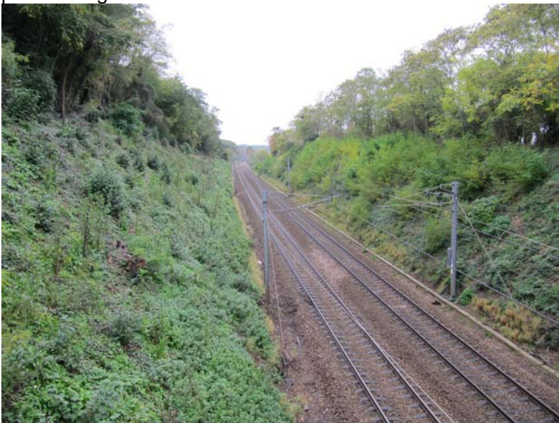
rssp007 : la voie ferrée Paris-Caen
