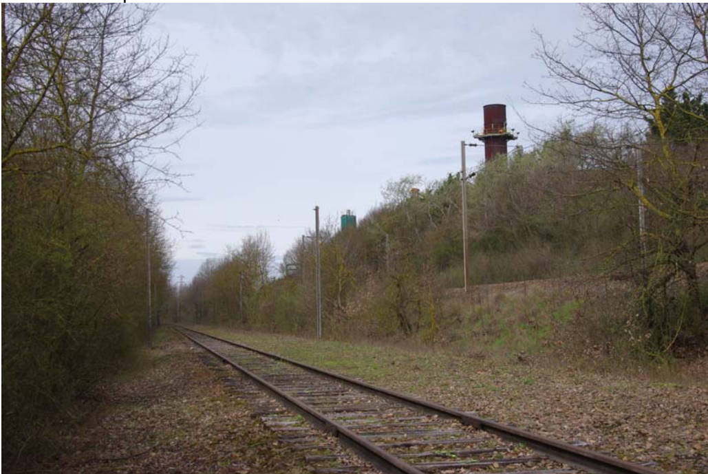
Porp008 : voie ferrée ligne de Paris-Mantes rive droite en haut, et dérivation vers le port, en bas.
