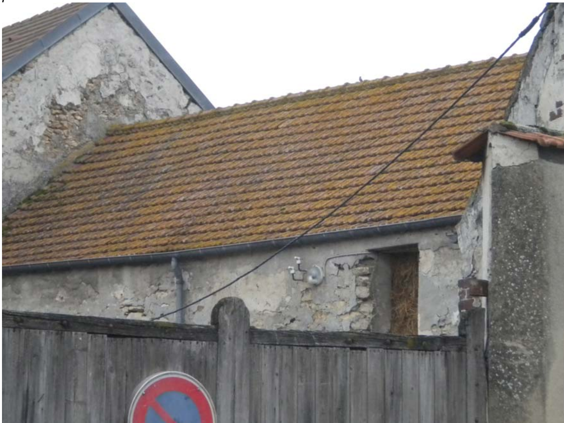
On aperçoit quelques vestiges d'enduits à la chaux sur les bâtiments de la cour mais un enduit au ciment a été aussi utilisé.
