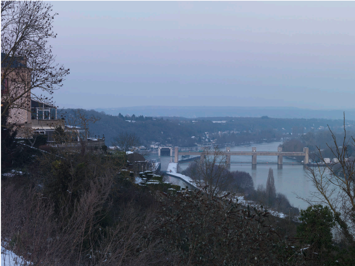
Le barrage de Méricourt.
