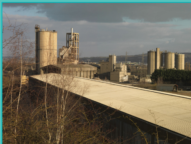
La cimenterie vue depuis la rue des Gamaches qui la surplombe
