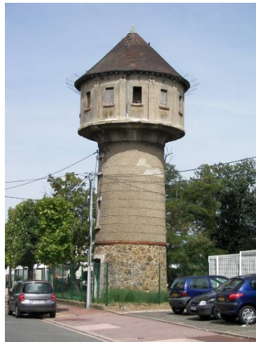
le château d'eau
