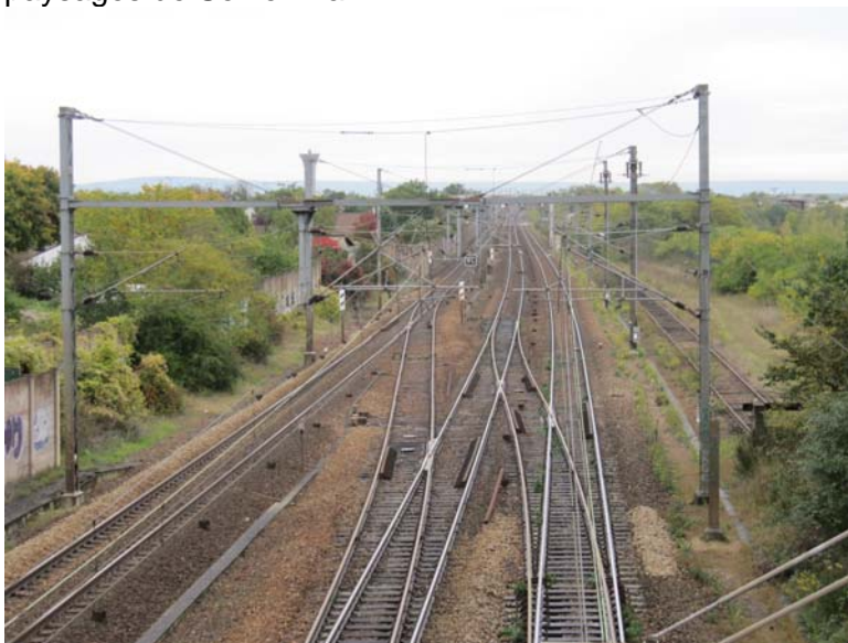
aubp004 : voie ferrée ligne de Paris-Mantes rive droite
