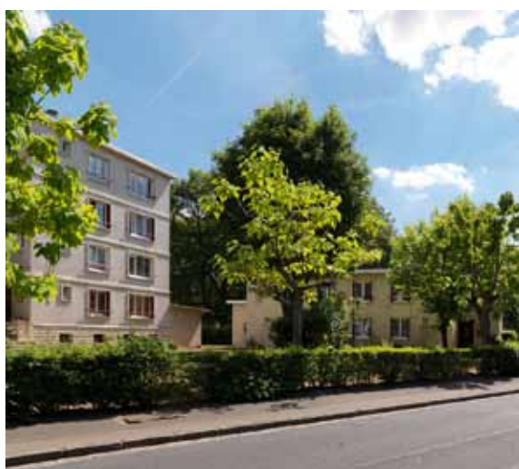
Barres R+4 le long de la rue et immeubles R+2 en épi.
