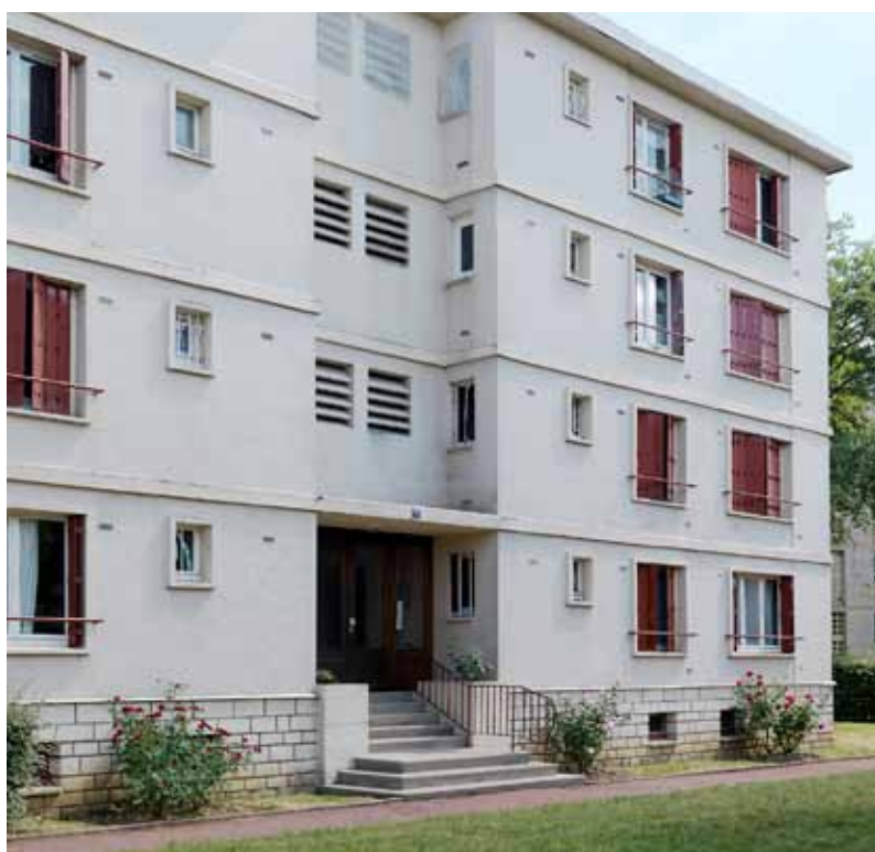
Entrée d'une barre R+4, avec cage d'escalier en renforcement.
