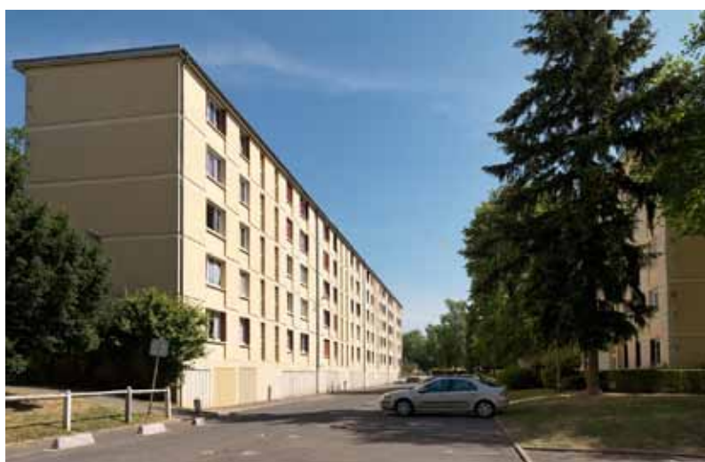
Pignons, parkings extérieurs et box fermés.
