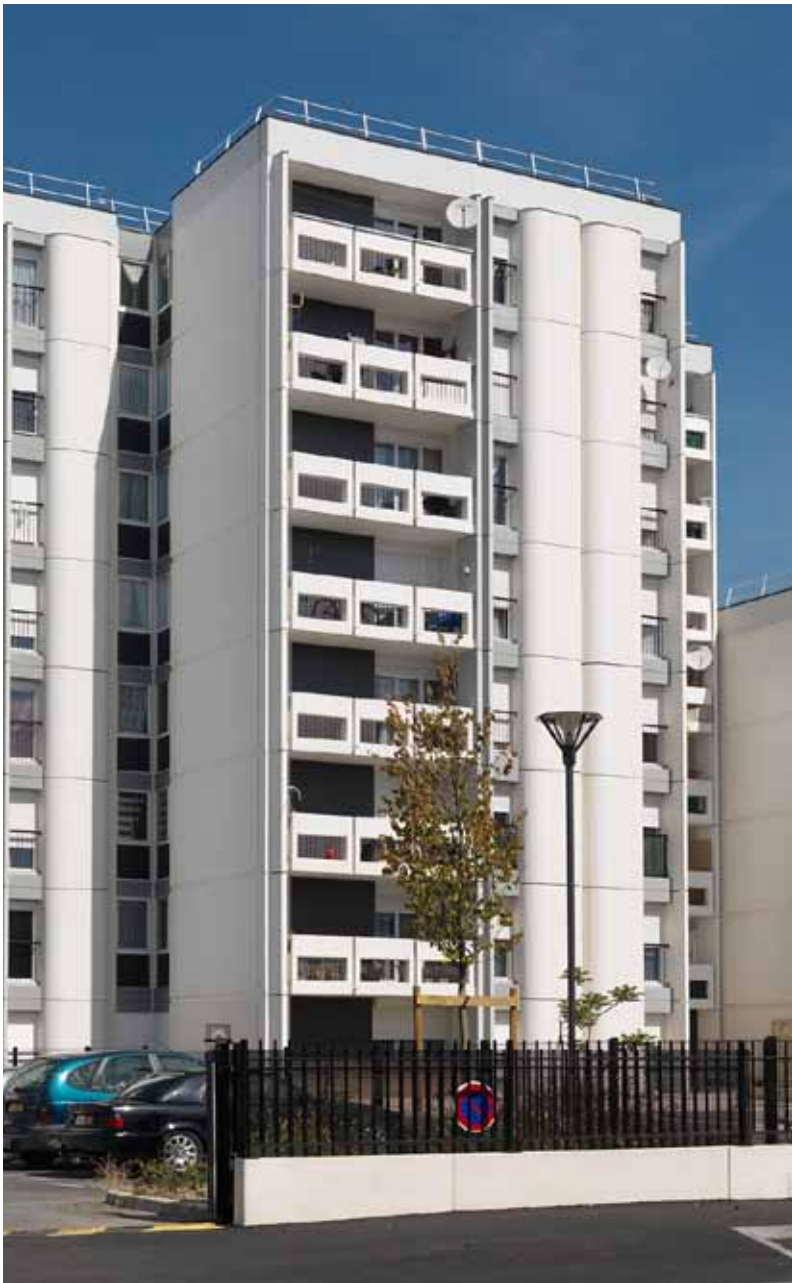
Vue d'ensemble des modules préfabriqués.
