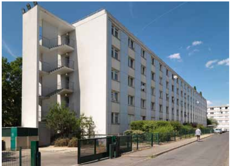
Vue générale du foyer de travailleurs depuis l'escalier extérieur sud. La rénovation a inclus un travail de résidentialisation du bâtiment.
